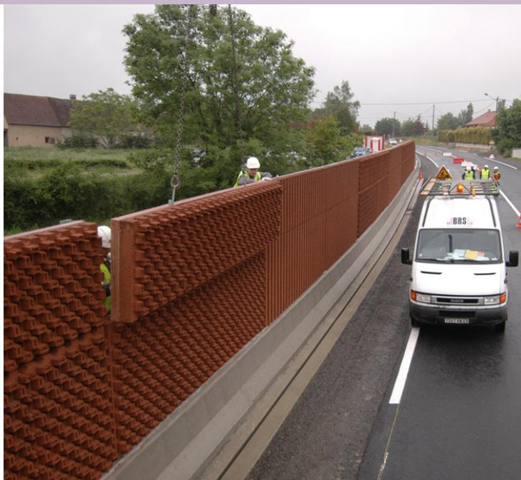
D'autres technologies permettent d'absorber les ondes sonores, tels des écrans dont la géométrie s'inspire des fractales, c'est-à-dire de des formes géométriques capables de se reproduire à l'identique à différentes échelles (Les branches du chou-fleur ou de l'arbre bronchique, etc).
