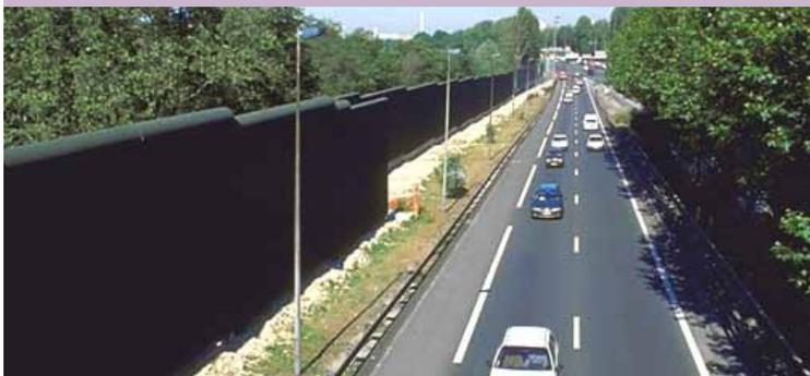
Au-delà de 40km/h, on considère que le bruit de roulement devient la source principale pour les véhicules légers. Cette limite est de 70 km/h pour les poids-lourds. En combinant les différentes sources de bruit, on peut évaluer la hauteur moyenne de génération du bruit pour chaque catégorie de véhicule.
